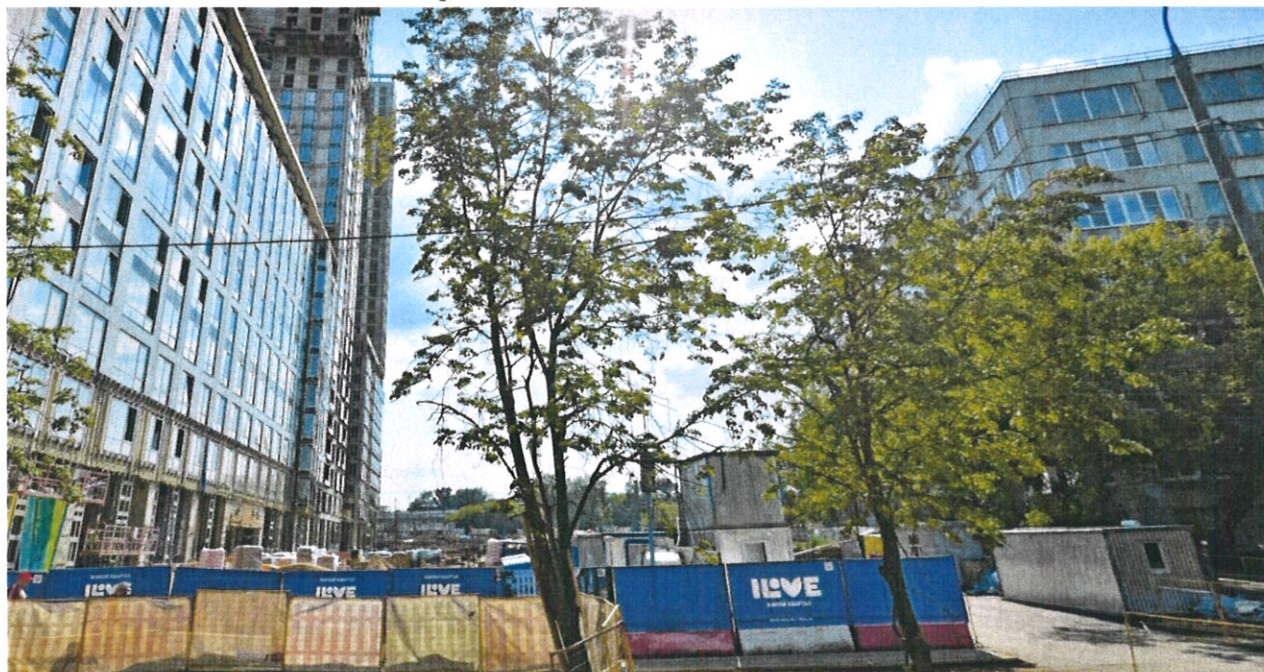
Фото № 73. Примыкание строительной площадки к исследуемому административному зданию.
